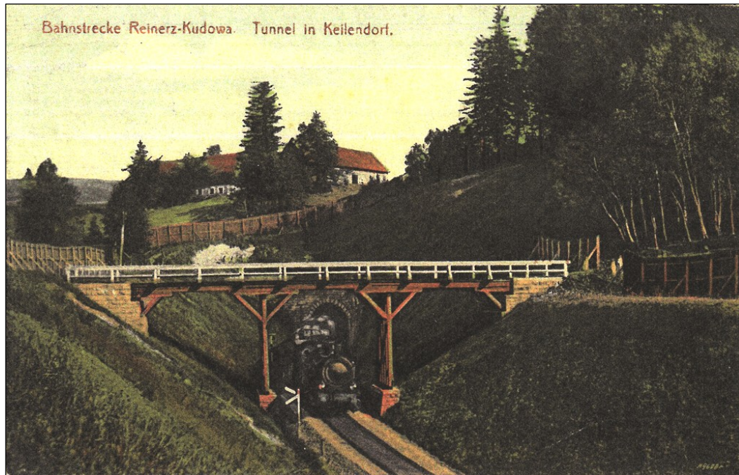
Bahn bei Keilendorf mit Tunnel und Bahnstrecke.
